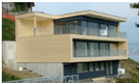
Neubau EFH Bracale, Wilen Burch Andi Planung Bauleitung, Wilen Flachdach- und Spenglerarbeiten – 300 m 2
