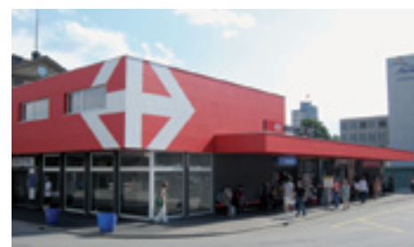
Provisorium Bahnhof Aarau Anliker AG Generalunternehmung, Emmenbrücke Flachdacharbeiten – 1000 m 2
