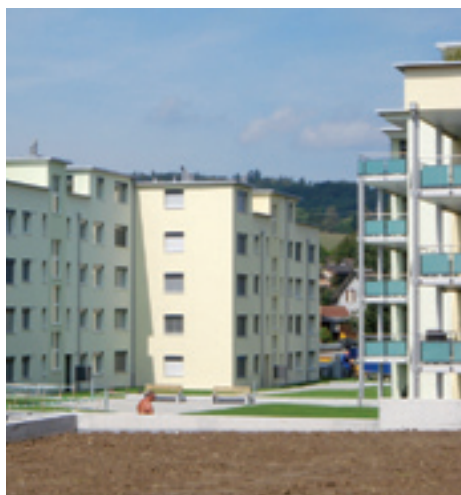
Wohnüberbauung Diamant, Safenwil Barko Immobilien AG Flachdach-, Spengler- und Blitzschutzarbeiten 5000 m 2
