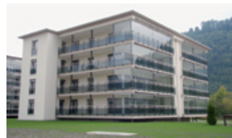
Wohnüberbauung Seehof, Stansstad Ammann Generalunternehmung AG, Stansstad Flachdach-, Spengler- und Blitzschutzarbeiten 900 m 2
