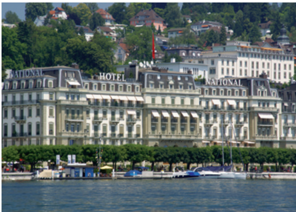
Das Grand-Hotel National in Luzern wird derzeit aussen saniert.
