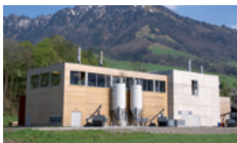
Neubau Holzverstromung Stans Oberdorf Slongo Röhlin Partner AG, Stans Flachdach-, Spengler- und Blitzschutzarbeiten 1000 m 2
