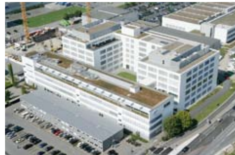
Diagnostikcenter Roche, Rotkreuz.
