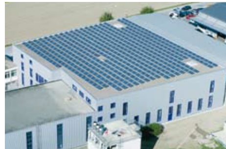
Flachdach mit Solaranlage, Bruno Peter AG, Büren an der Aare.
