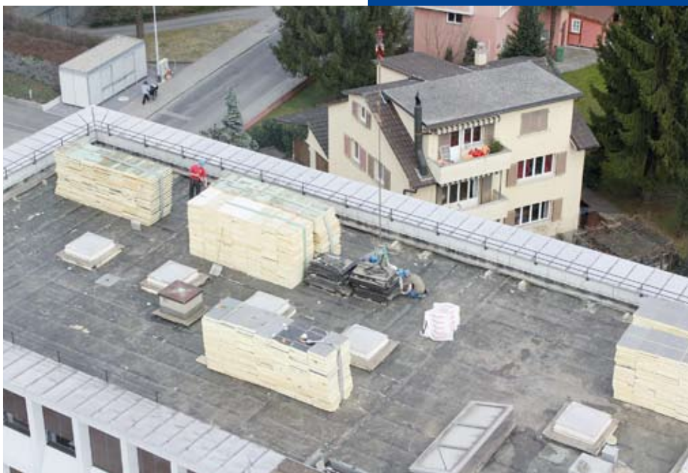
Abbrucharbeiten am bestehenden Flachdach.
