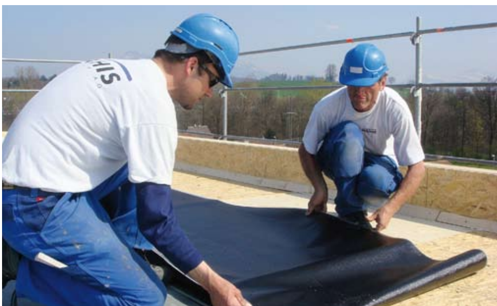
Mitarbeiter der Mathis Flachdach AG verlegen die Dampfsperren.
